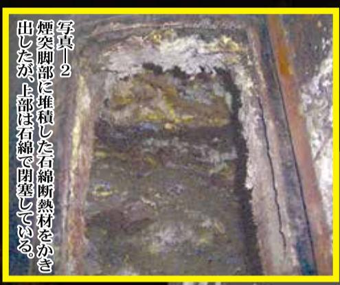
写真-1 はく落し堆積した石綿断熱材。
